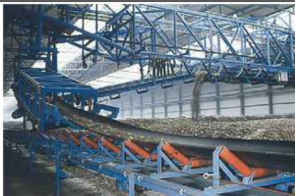
ブリュッセルの大型コンポストプラント内部(施設説明パンフより)
